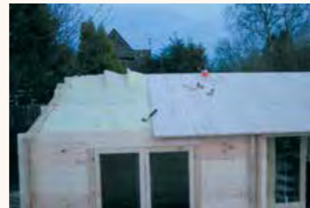
En als toevoeging hebben deze type blokhutten een dubbelschalig dak met isolatieruimte.
