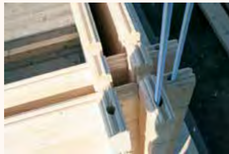
Twinskins zijn dubbelwandig (2x 40 of 2x 50 mm wanddikte) en hebben een tussenruimte van 14 mm.
